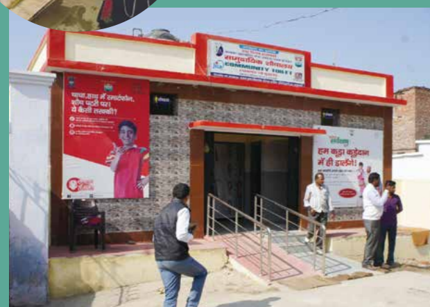
バラナシ市内に完成した公衆トイレ。
