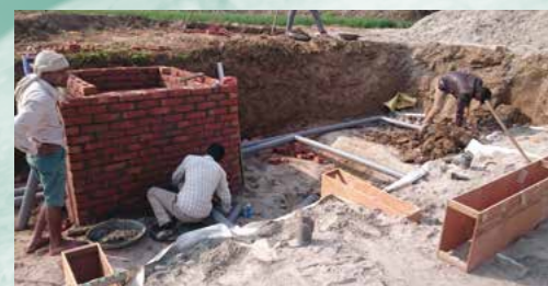
環境配慮型トイレ「TSS」は、下水道や電気設備のない地区や施設でも設置することができる。
